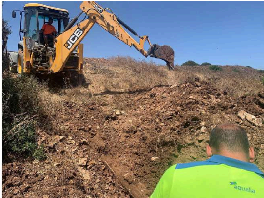
La reparación de la tubería dañada el pasado fin de semana.
