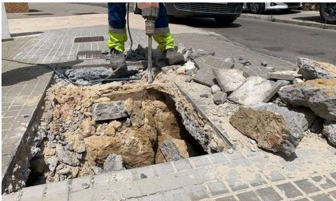
Obras en Tarifa
